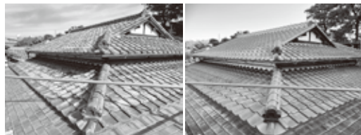
1期工事 左/改修前、右/改修後
